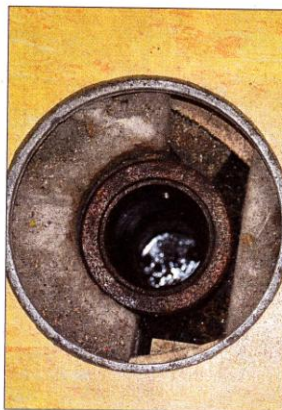
Schaut man in eine Buchse im Hallenboden, sieht man, wo das Wasser steht.
